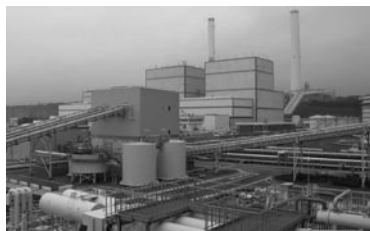
広野火力発電所
