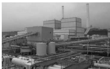
広野火力発電所
